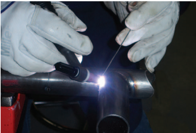
Fig. 7 — Establecer un charco de soldadura.
